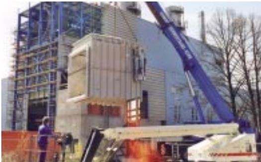
**2001** Lieferung eines weiteren DIVERTERS NW 4.620 x 4.240 mm für die Linie 3 des GUD-Kraftwerkes Linz (Bild links).
