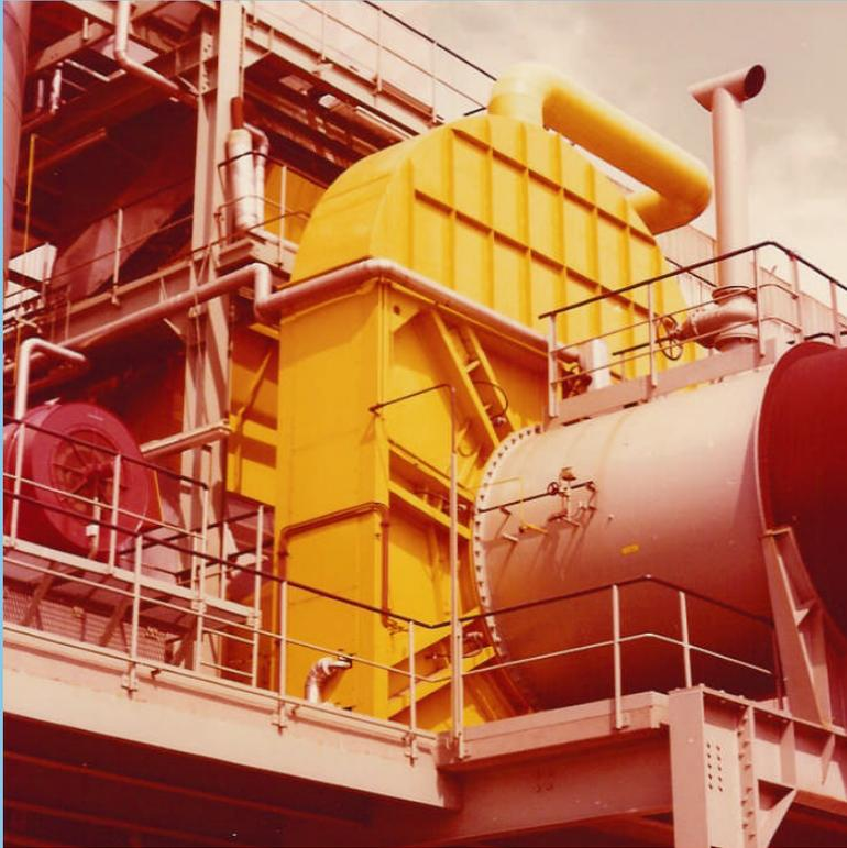
**Sichelschieber NW 3000** als Hauptabspernung vor einer gichtgasgefeuerten Kesselanlage des Kraftwerkes Mittelsbühren. Die Absperrung entspricht einem Blindflanschabschluss nach UVV. Die Betätigung des Dichtrahmens und der Blindscheibe erfolgt hydraulisch. Der Schieber ist mit einer gasdichten Verkleidung mit Entlüftung versehen. Der Innenraum wird bei Kälte beheizt.
